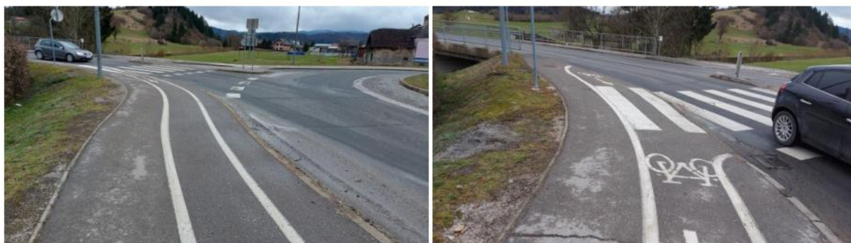
Slika 4: Navezava v Rondoju Logatec
