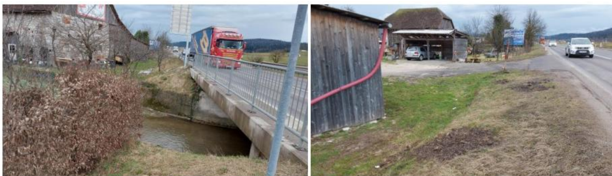
Slika 5: Most čez Logaščico in Dostop 1 – pomanjkanje infrastrukture
