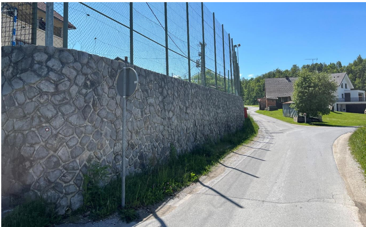
Slika 6: pogled na obstoječi podporni zid ob obstoječi javni poti, ki podpira igrišče. Zid je v dobrem stanju brez kakšnih koli vidnih razpok.
