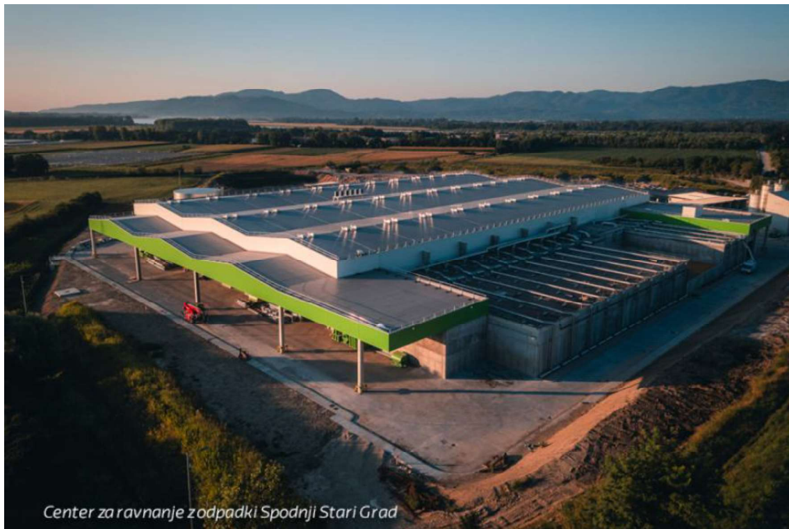
Slika 1: Center za ravnanje z odpadki Spodnji Stari Grad, Krško (novozgrajeni proizvodni objekt)
