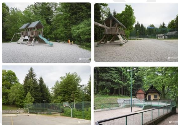
Slika 3. Stanje spremljevalnih objektov v športnem parku Rovte.
