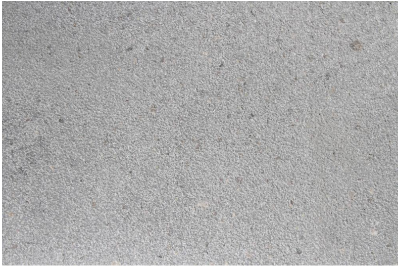
Primer štokane površine betona.
