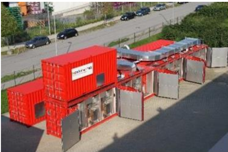
Slika 20: Kontejner za tračni sušilnik NEWtrainer® Sdryer KX Z-100/100-0.5 za sušenje dehidriranega blata iz komunalne odpadne vode
